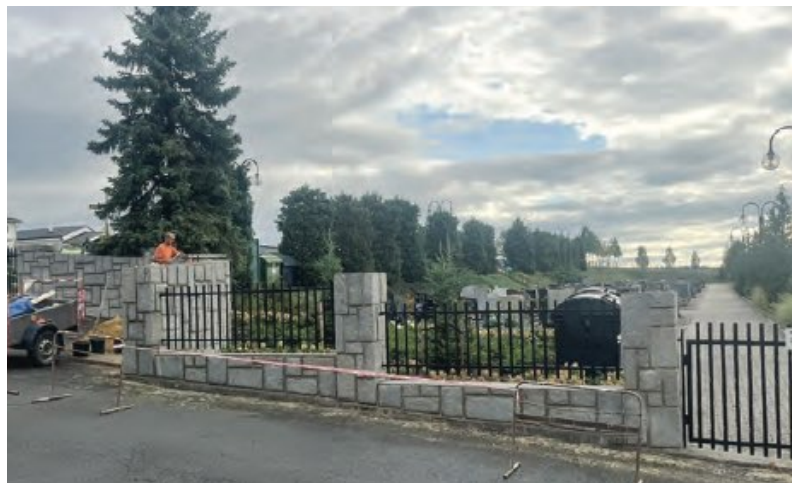
Oprava plotu nového hřbitova
