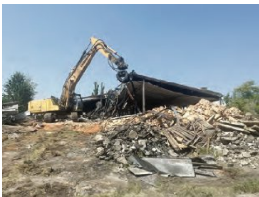
Bourací práce v bývalém JZD
