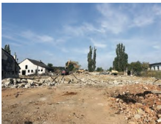
Bourací práce v bývalém JZD
