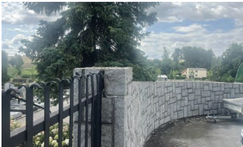
Oprava plotu nového hřbitova
