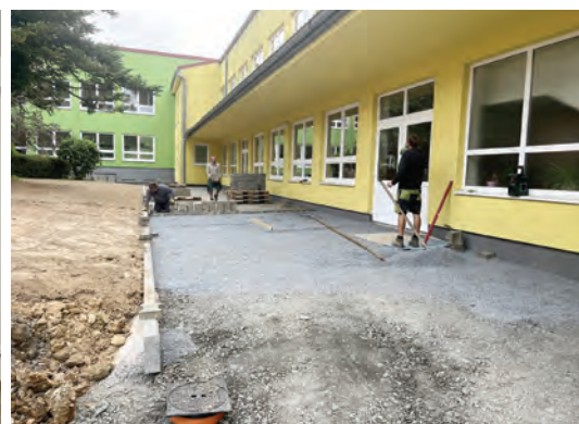
Opravy ve škole
