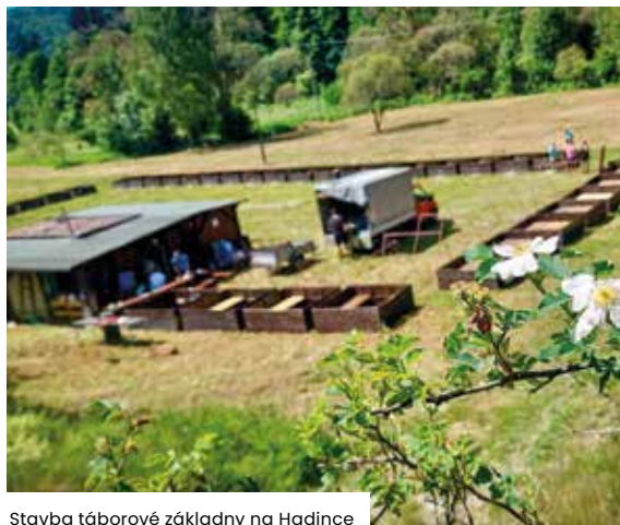
Stavba táborové základny na Hadince
