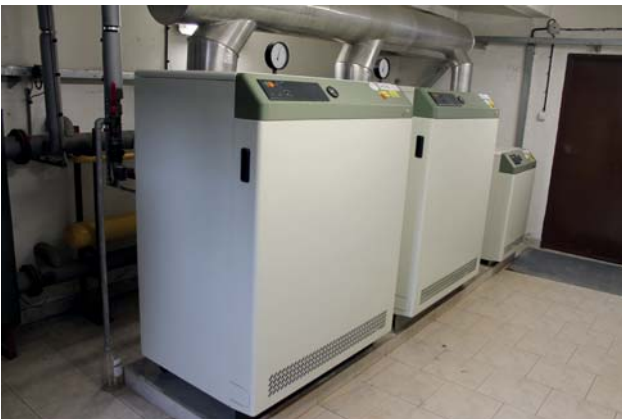
Rekonstrukce plynové kotelny – starý stav
