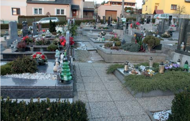
Oprava hřbitova III. etapa – starý stav
