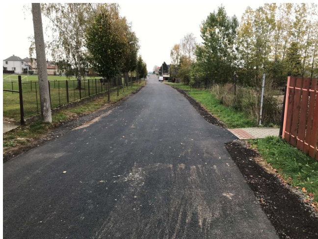
Místní komunikace ulice Horní
