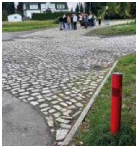
Sloupek Z 11g označuje vyústění účelové komunikace na jinou pozemní komunikaci.
